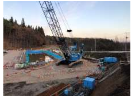
鋼矢板打設状況
