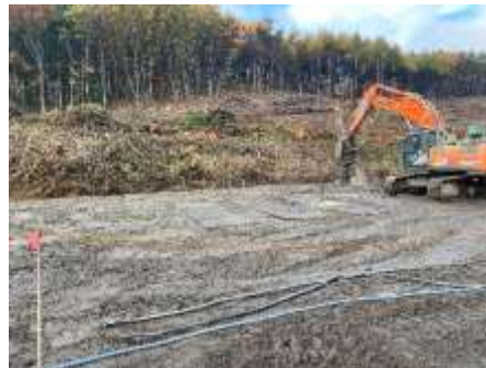
地盤改良状況
