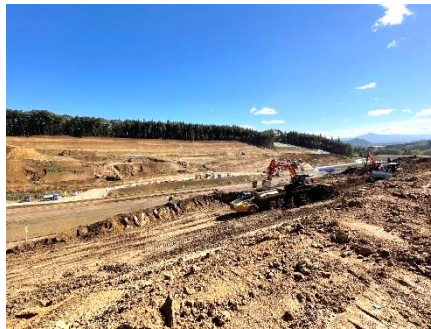
掘削状況（施工中）
