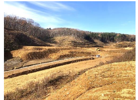
盛土状況（施工中）
